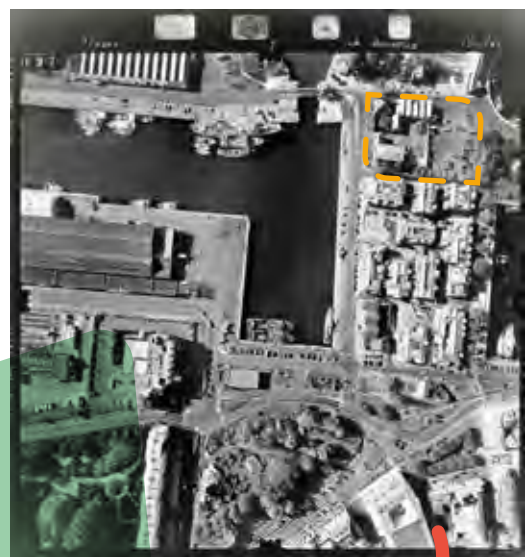
Vue aérienne du Gabut et du bassin des Grands Yachts - 1992. En pointillé, l'emprise de réflexion de la concertation.
