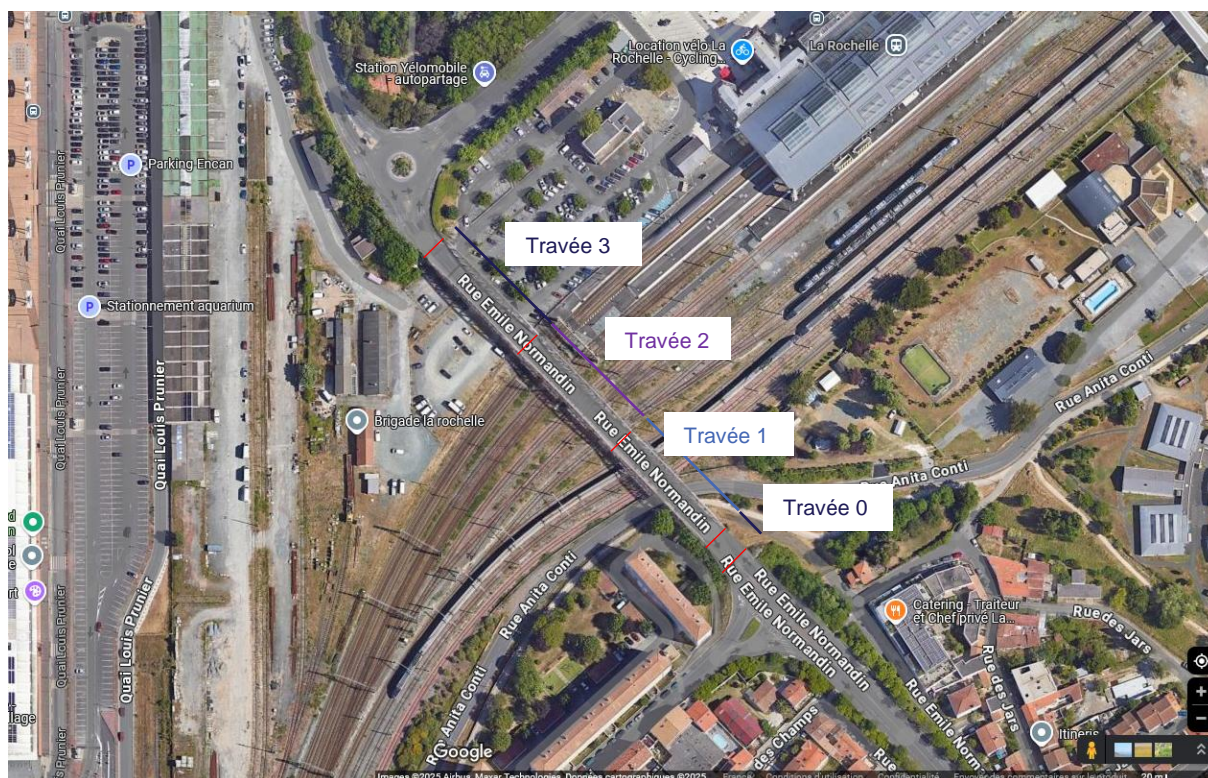
Figure 10 : Identification du pont de Tasdon
