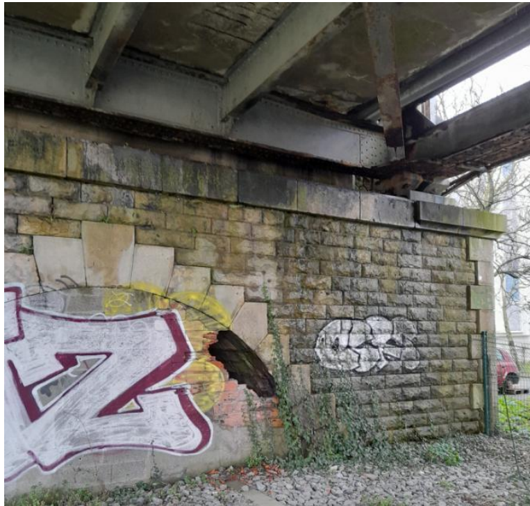
Figure 7 : Travée 0 à partir de la pile n°1
