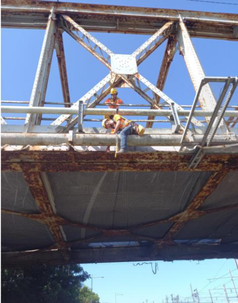
Figures 3 : Filets de protection au-dessus des contreventements
