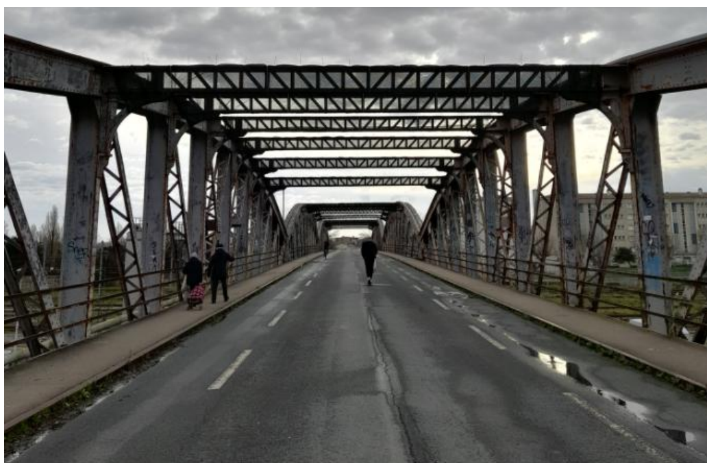
Figure 5 : Filet entourant complètement les contreventements supérieurs
