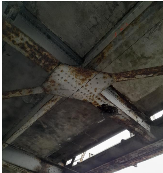
Figure 4 : Filet posé sous le contreventement inférieur
