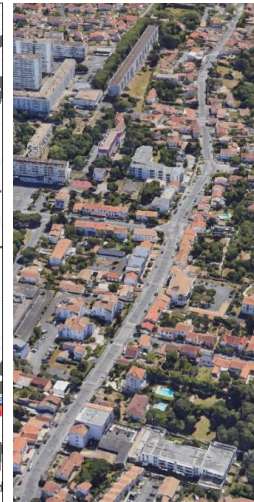
Vue de l'ouest
