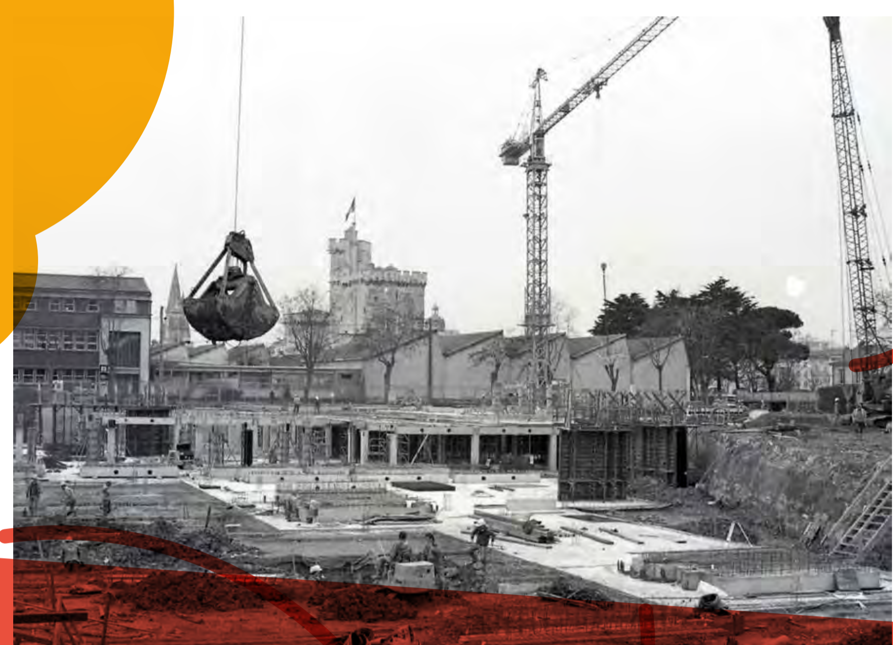
Les travaux du Gabut démarrent.
