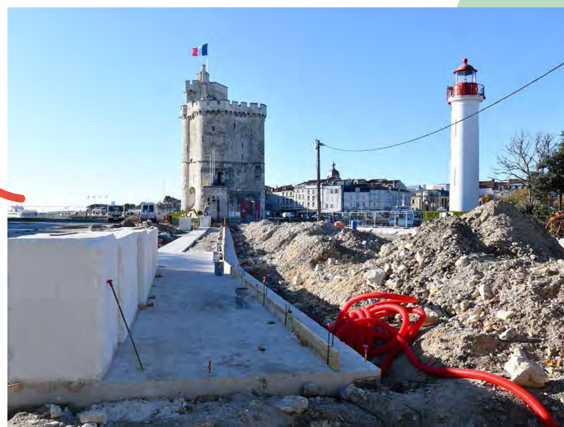
Travaux du PAPI (prévention des inondations) au niveau du Square de l'Armide.
